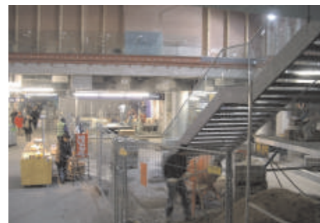
Bauarbeiten im Bereich Hauptbahnhof / UESTRA
