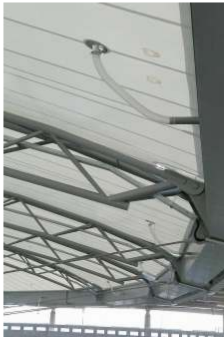
Dachentwässerung Volkswagen Arena
